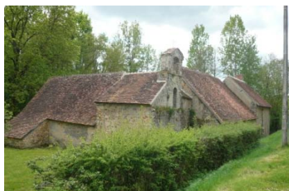
L'Hôpital : ancienne maladrerie
